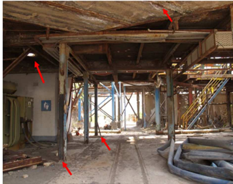
Teilweise erhebliche Korrosionsschäden an Stützen, Trägern und Bodenplatten
