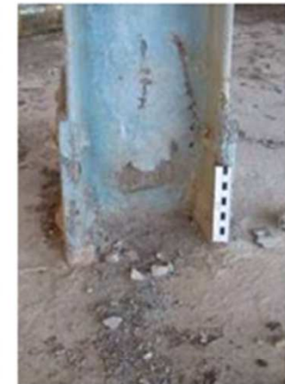
Teilweise erhebliche Korrosionsschäden an Stützen, Trägern und Bodenplatten
