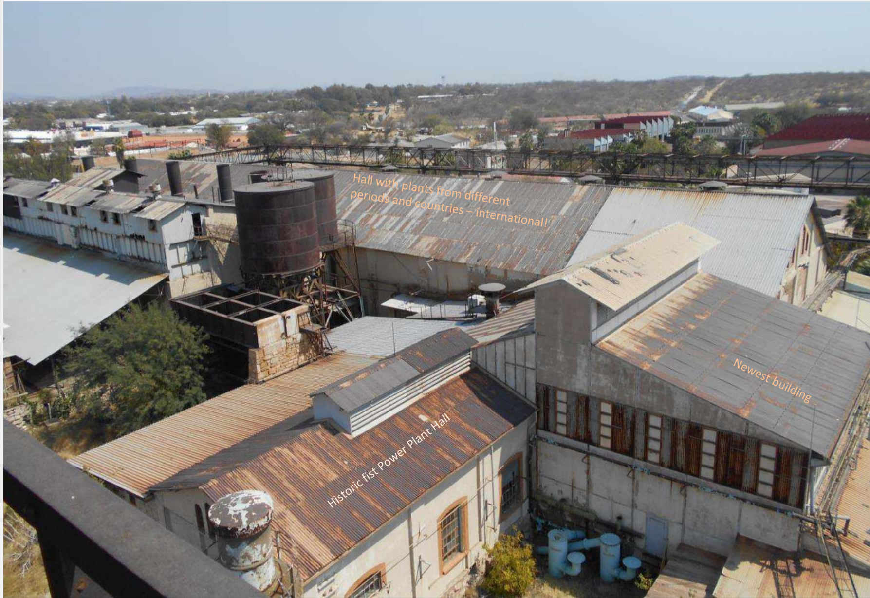
VIEW FROM PLATFORM: Power plant hall with added constructions - power machines from different periods and countries; Maschinenhalle mit angefügten Funktionseinheiten, Sicht von Friedrich Wilhelm Fördergerüst mit Aggregaten aus unterschiedlichen Zeiten und Ländern.
